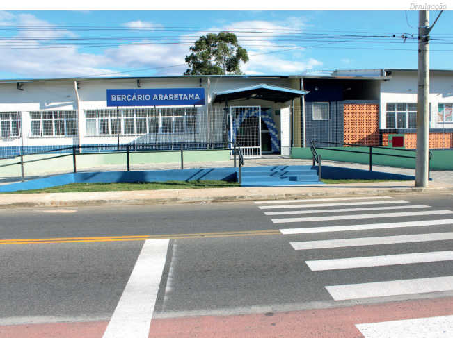
Novo equipamento no Araretama
