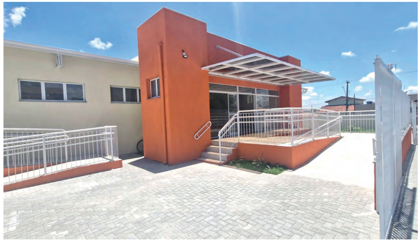
Unidade em fase de finalização no Mantiqueira
