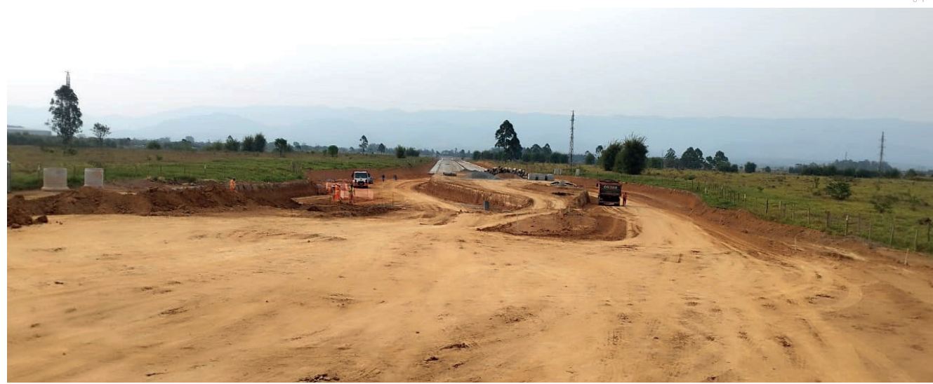
O aterro da rampa de acesso ao viaduto vem sendo trabalhado
