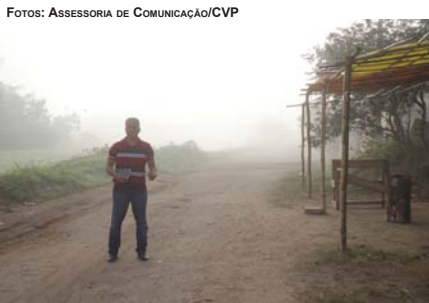
CONSTRUÇÃO DE GUIA E ASFALTAMENTO NA RUA ARGEMIRO CYPRIANO
