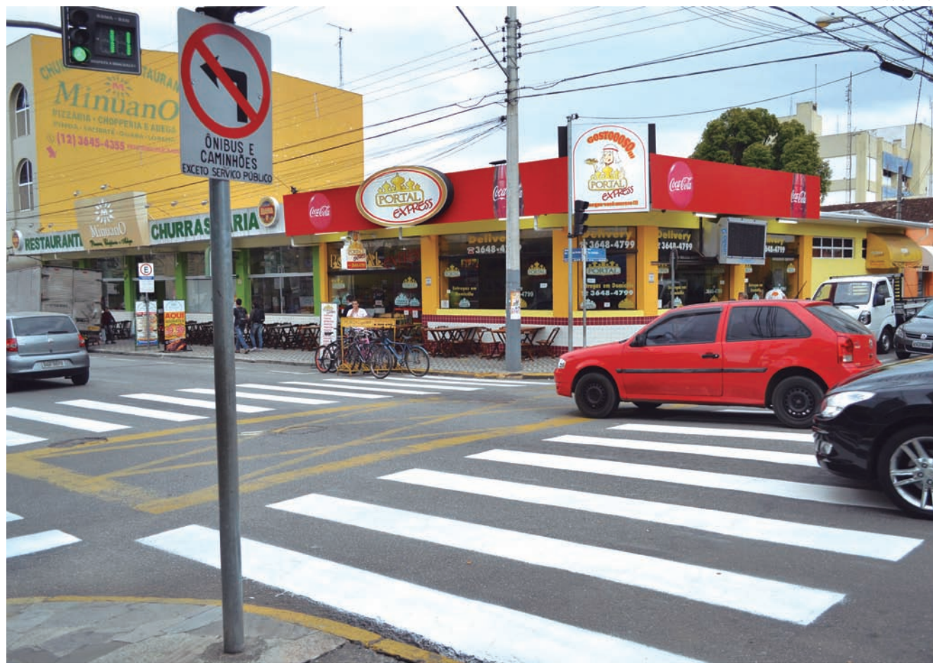
Reforço na sinalização evita acidentes nos cruzamentos mais movimentados do centro da cidade
