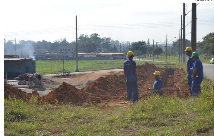
A escola está sendo construída na entrada do Morumbi
