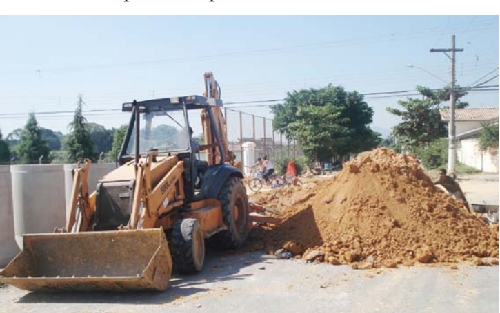
OBRAS INICIADAS NA RUA BENEDITO GALVÃO DE CASTRO, NO BAIRRO MARIETA AZEREDO
