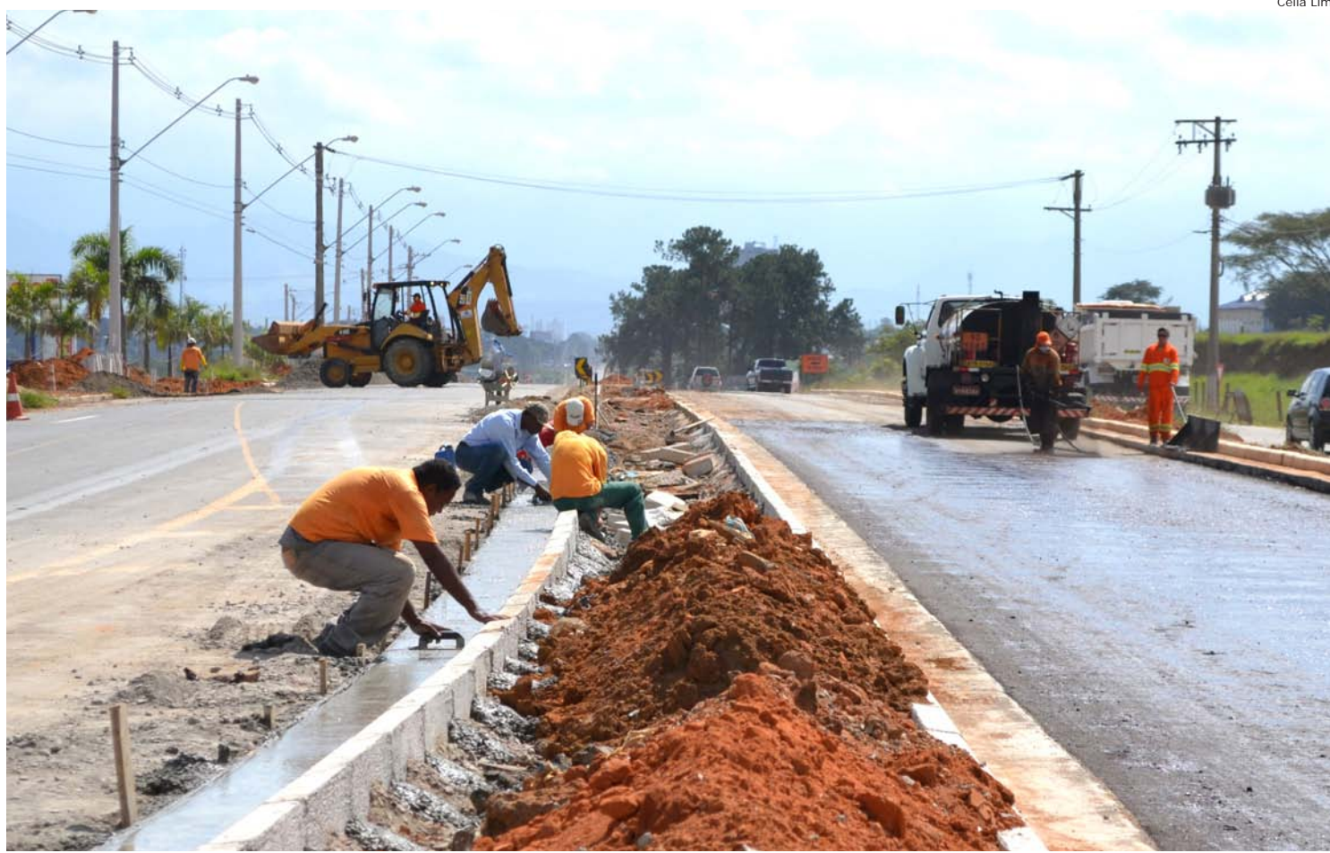
Obra de 4km de extensão, começa pelo Distrito Empresarial Dutra e segue até posto de combustíveis na avenida
