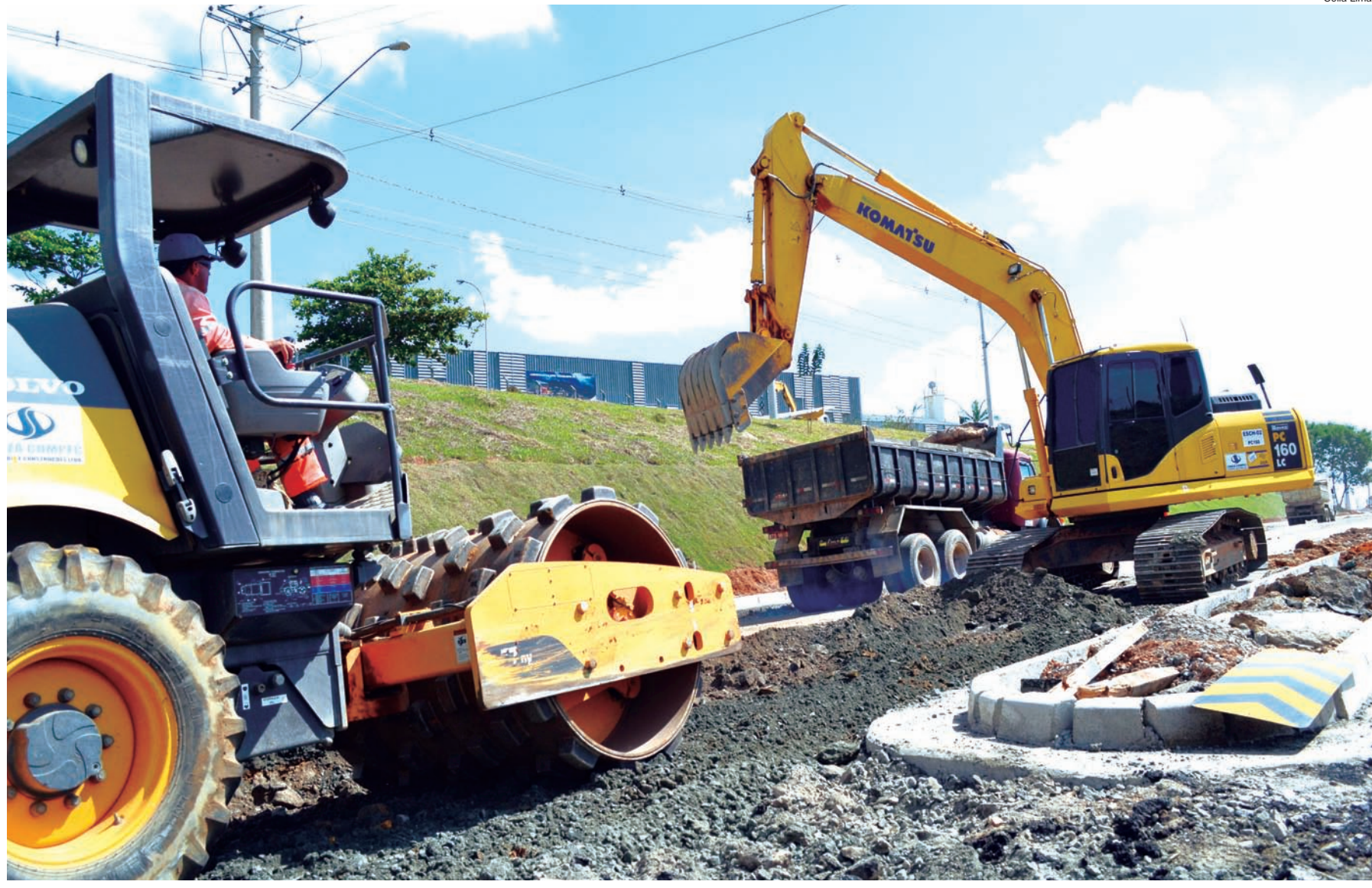
Duplicação da principal avenida vai facilitar o trânsito, evitar acidentes e contribuir com o desenvolvimento da cidade
