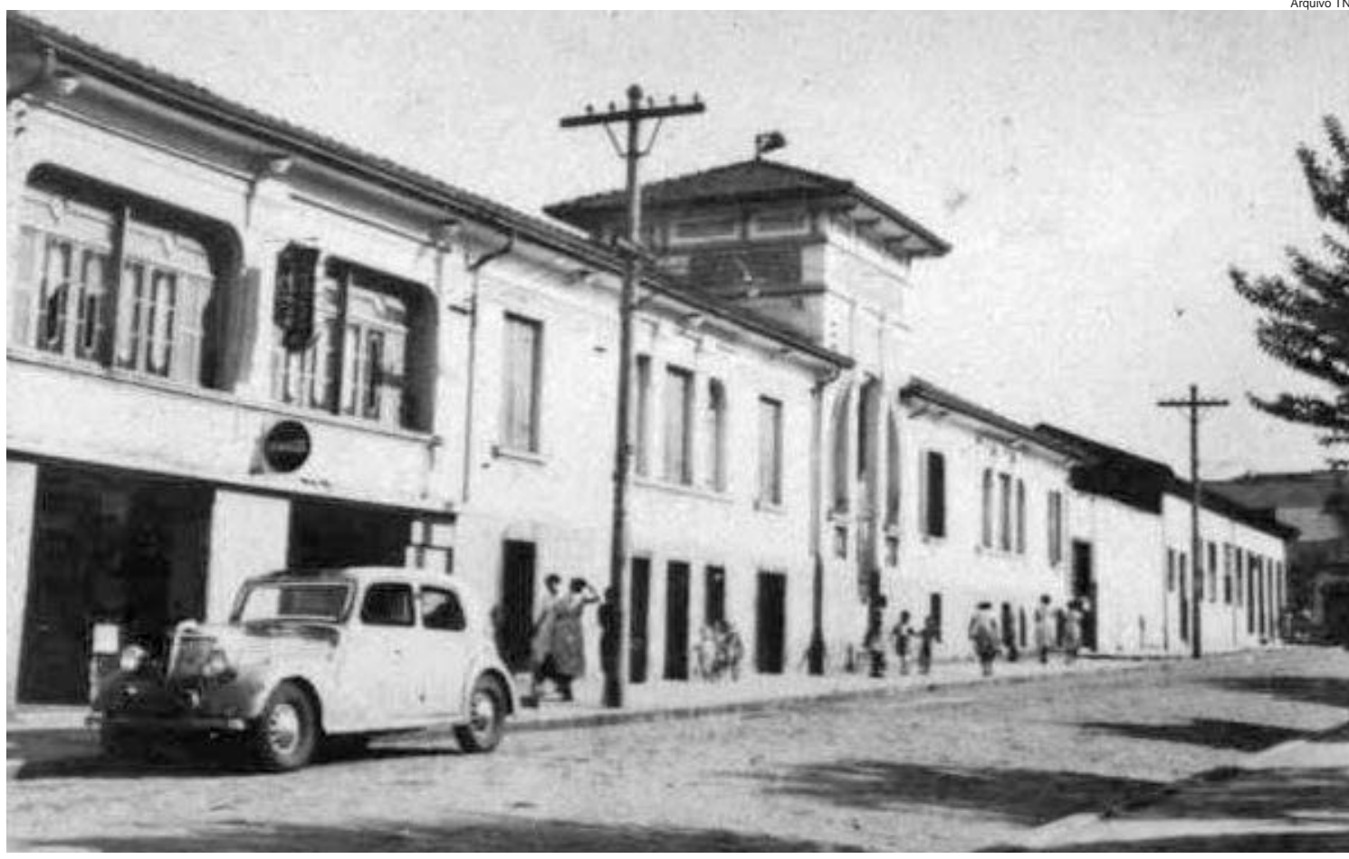
A direita, telhado mais alto, prédio onde funcionou o Clube Literário e Recreativo. Antiga residência de um dos ex-prefeitos de Pindamonhangaba, o Dr. Benjamin Pinheiro. A casa ficava ao lado da praça Monsenhor Marcondes (local atualmente ocupado por edifício de apartamentos e estabelecimentos comerciais)
