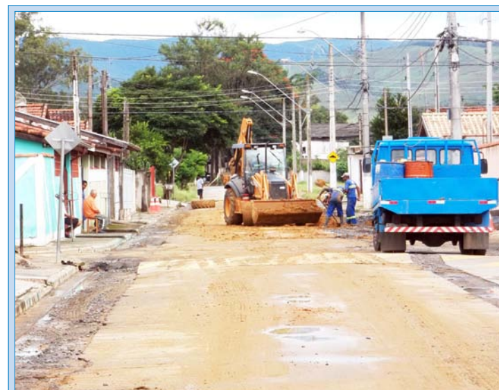
Obras garantem saneamento e evitam enchentes
