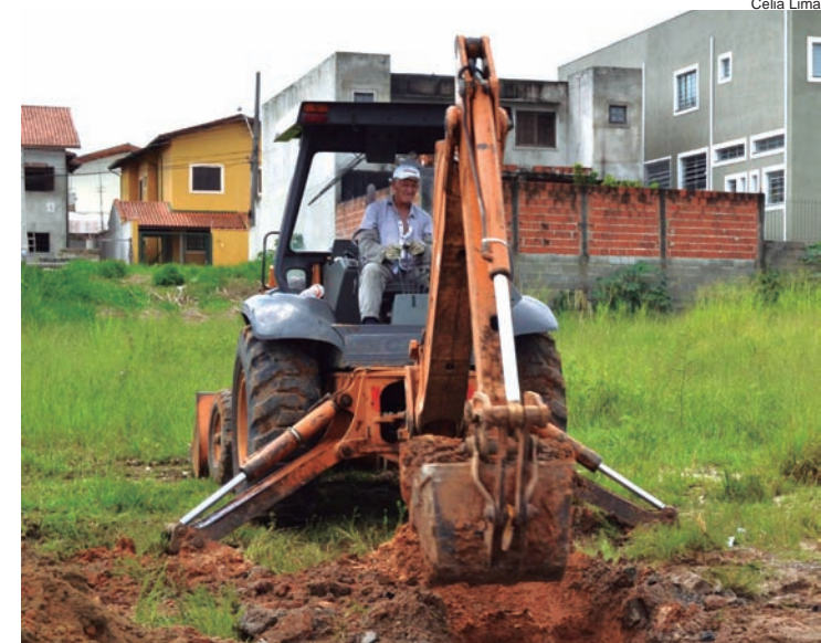
Com a obra, a intenção é evitar alagamentos no local
