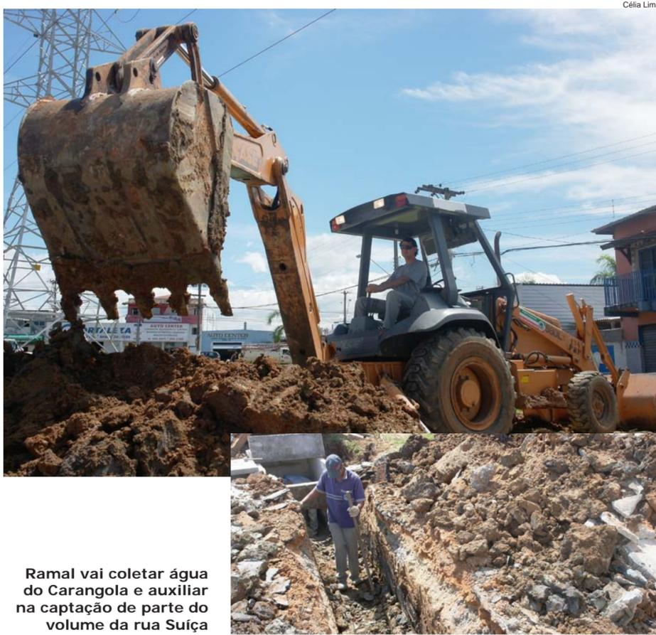
Ramal vai coletar água do Carangola e auxiliar na captação de parte do volume da rua Suíça
