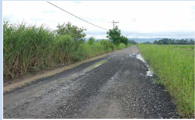
Muitos trechos receberam pedregulhos
