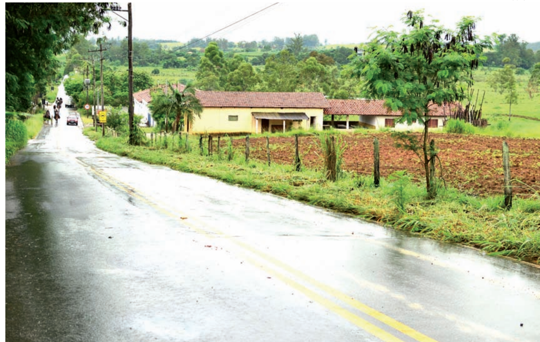
Manutenção na “Jesus Antônio de Miranda” melhora visibilidade da via
