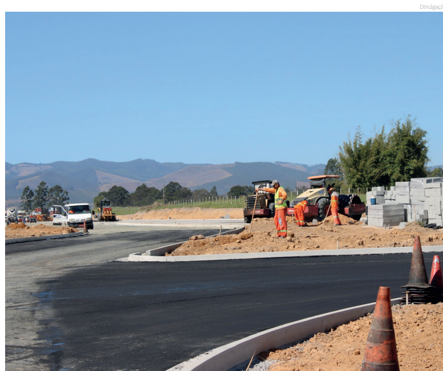
Trecho já pavimentado da via estrutural
