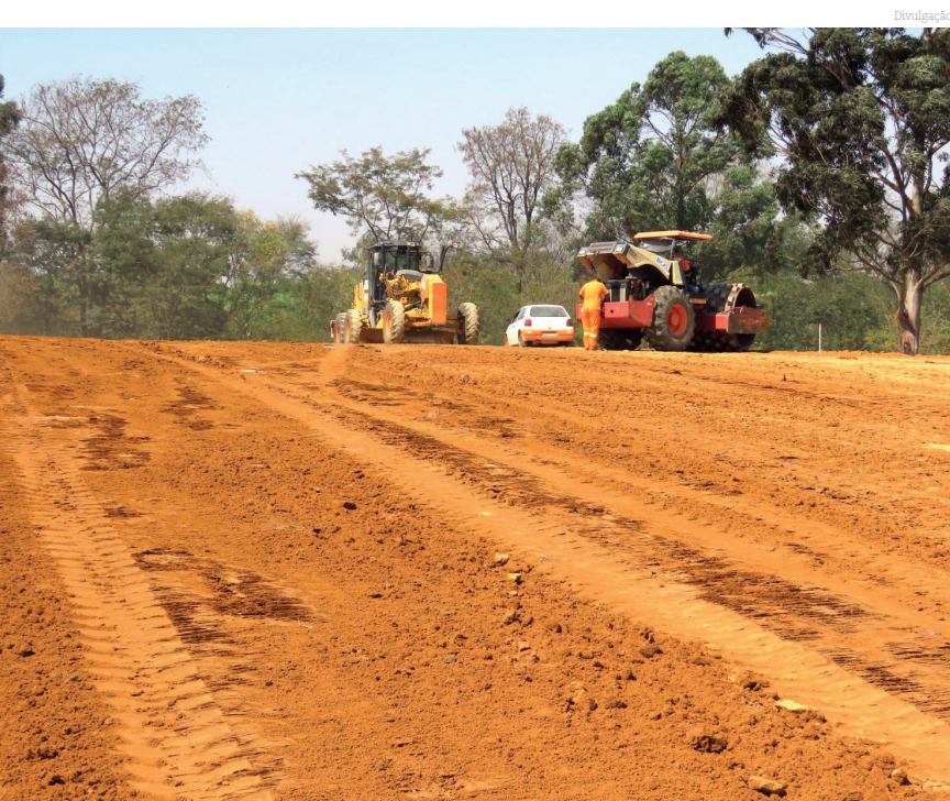
Preparo de base e aterramento para alças do viaduto
