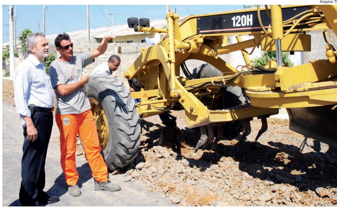
Prefeito acompanha obra de pavimentação asfáltica no residencial Liberdade
