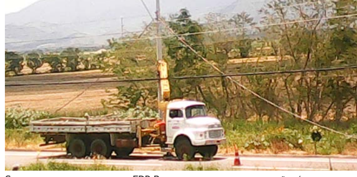
START – EMPRESA TERCEIRIZADA DA EDP BANDEIRANTE, INSTALANDO ILUMINAÇÃO PÚBLICA EM VIA DO MOMBANÇA I.
