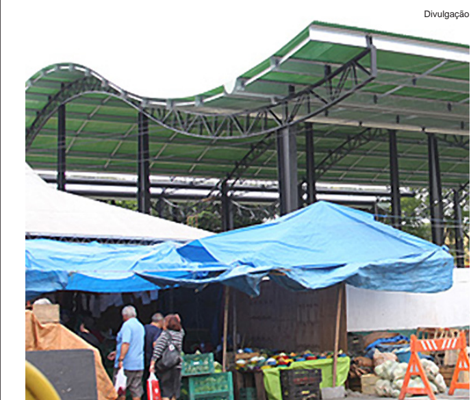
A nova cobertura da Praça da Liberdade
