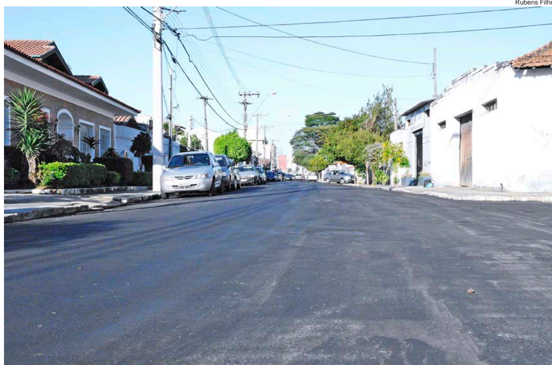
Rua recapeada antes de receber a sinalização horizontal, no bairro Boa Vista
