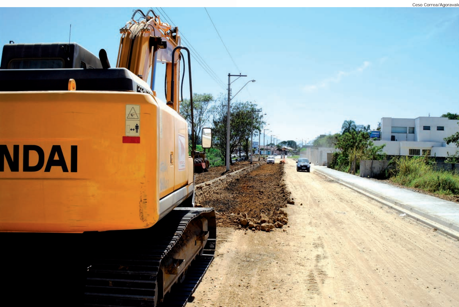
Máquina trabalha na construção de calçada e na preparação do solo para receber a pavimentação asfáltica
