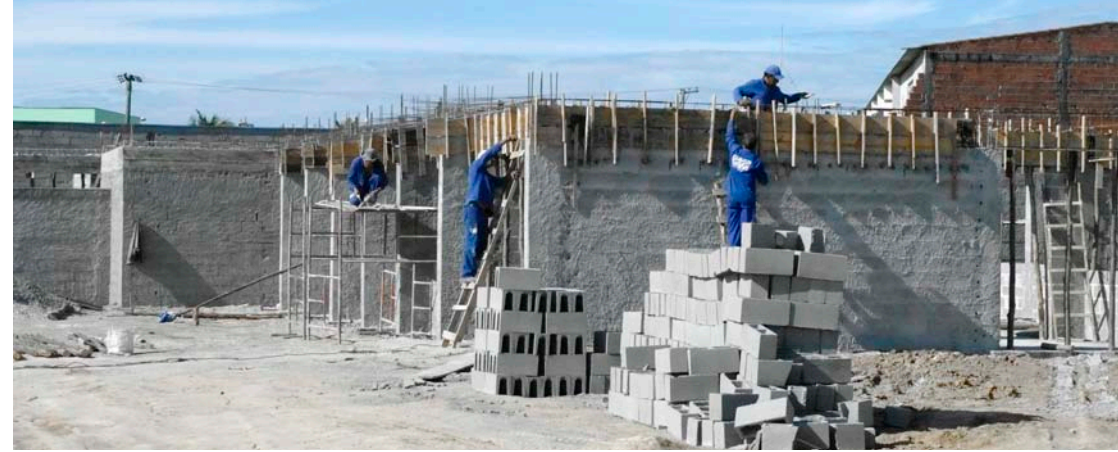
As equipes da Prefeitura já levantaram as paredes da nova UBS
