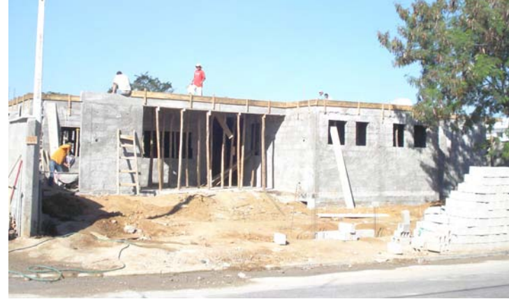
OBRAS ESTÃO ACELERADAS NA CONSTRUÇÃO DO PSF DA VILA VERDE
