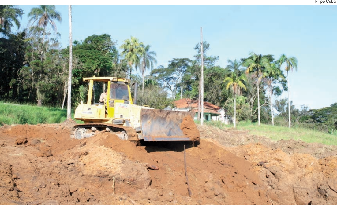
Trator já começou o trabalho de terraplanagem do local
