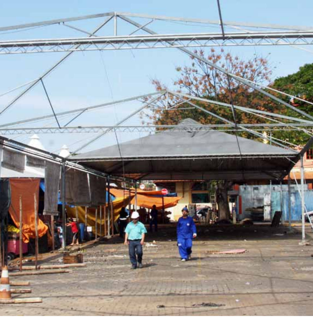
Praça ganhará cobertura metálica com áreas de ampliação
