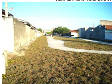
ÁREA VERDE DO MORUMBI ESTÁ COM AS OBRAS BEM ADIANTADAS; VEREADOR QUESTIONA QUALIDADE DA GRAMA IMPLANTADA NO LOCAL
