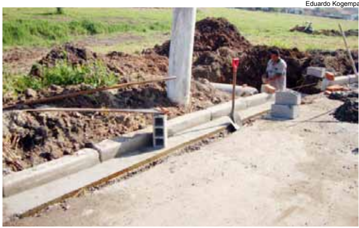
Construção de bocas de lobo e reparo em guias
