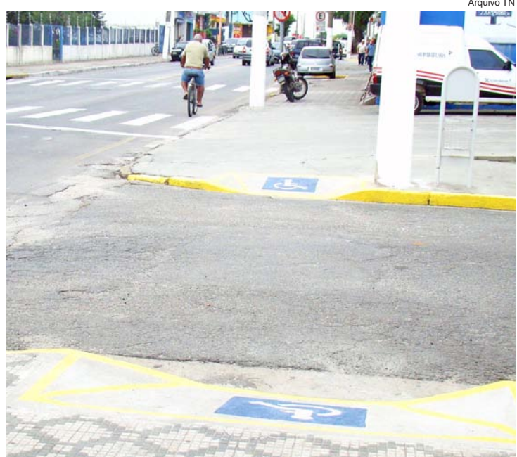
Ações de inclusão: rampas de acesso nas calçadas
