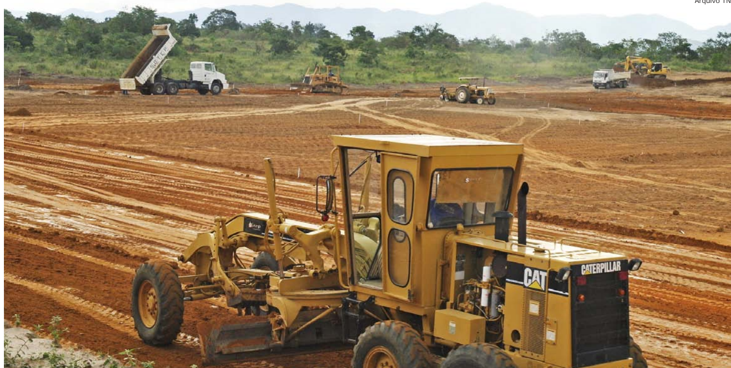
Obras de construção da unidade industrial da empresa mexicana em Coruputuba tiveram início em fevereiro
