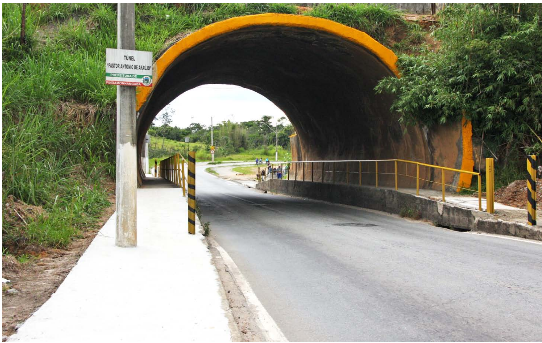
Ao todo, foram construídos 150 metros de calçadas nas proximidades do túnel sob a via férrea, na região do residencial Castolira
