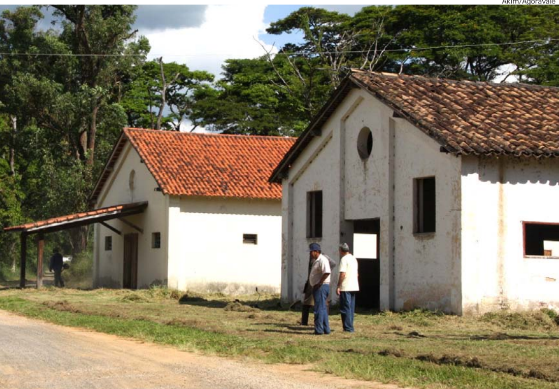
Galpões serão reformados para abrigar área cultural
