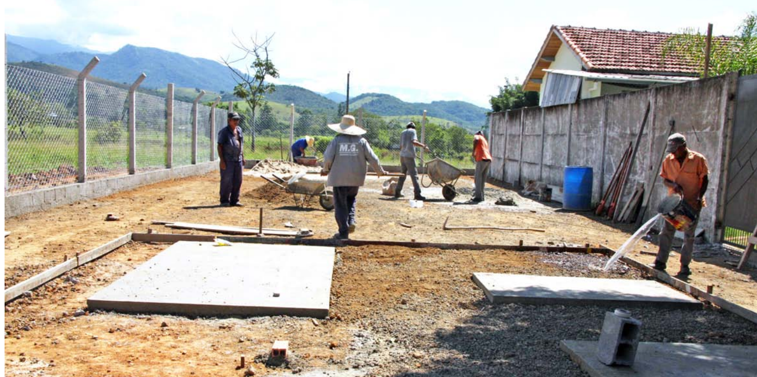
Obras para implantação da nova AMI-Academia da Melhor Idade estão em andamento
