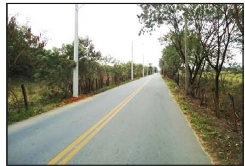
POSTES COM ILUMINAÇÃO FORAM INSTALADOS NA ESTRADA DO ATANÁSIO NO ANO PASSADO
