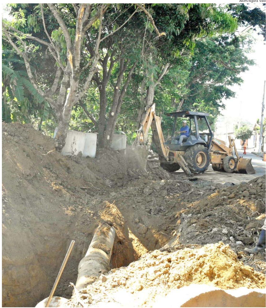
Várias galerias de águas pluviais foram trocadas ou expandidas por toda a cidade
