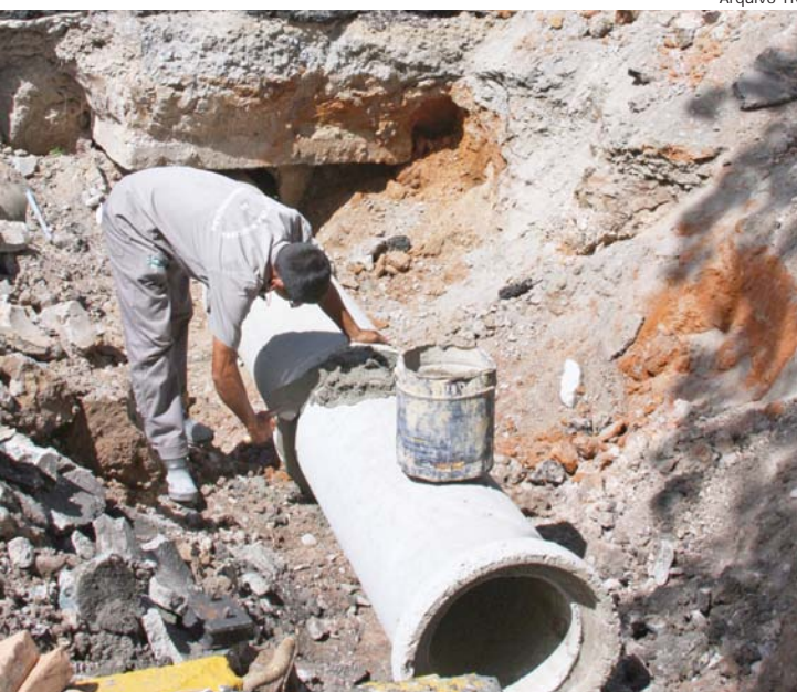
Obra em 2010 na esquina da EE Alzira Franco
