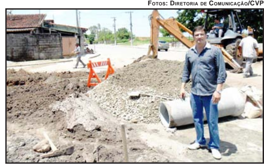
VEREADOR DR. ISAEL CONFERIU DE PERTO AS OBRAS EM FASE DE CONCLUSÃO NO BAIRRO ARARETAMA
