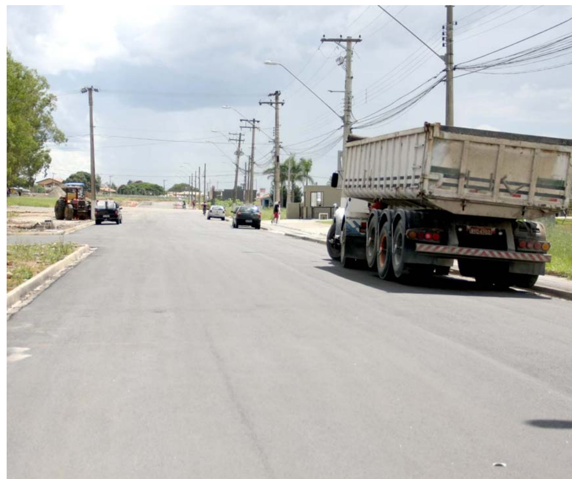
A segunda fase da obra tem previsão para terminar no próximo mês
