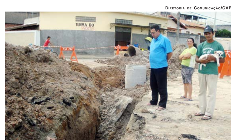
MORADORES OBSERVAM OBRAS DA GALERIA DE ÁGUAS PLUVIAIS NA RUA BENEDITO MARCONDES DE BARROS, NO CIDADE JARDIM
