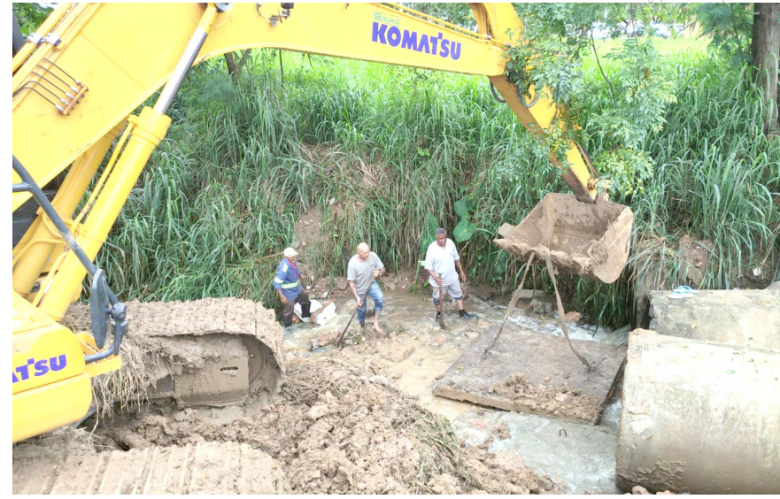
Com a drenagem, os problemas foram solucionados no córrego
