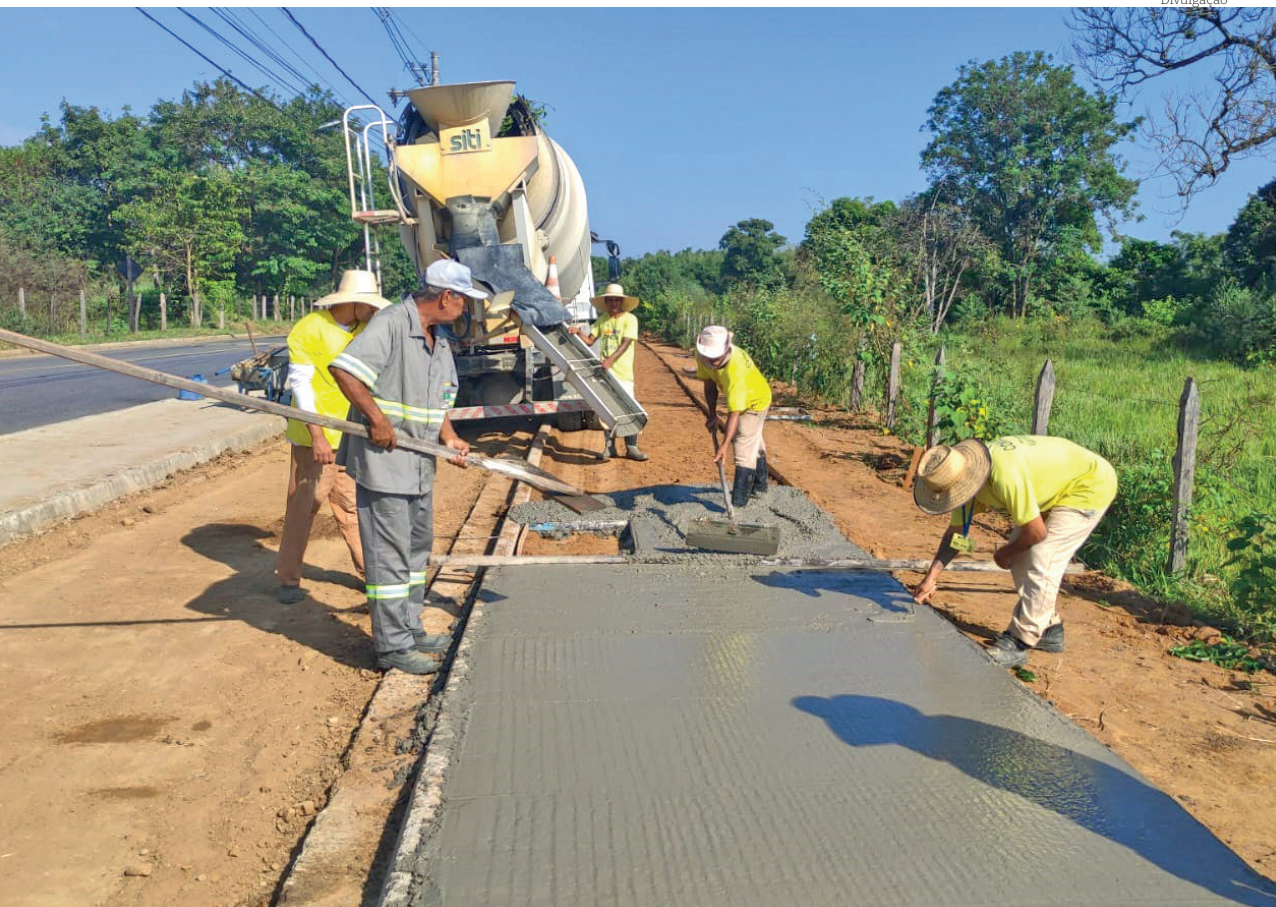
Servidores realizam serviços de concretagem de calçada e preparo da base da pavimentação
