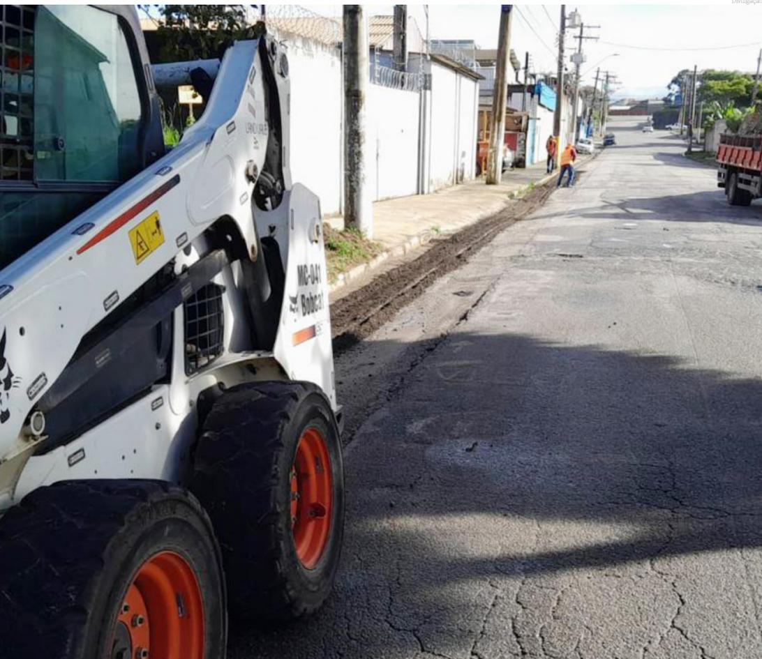
Foto mostra o início das obras na Estrada Municipal Santa Cruz, com as ações de fresagem do piso asfáltico
