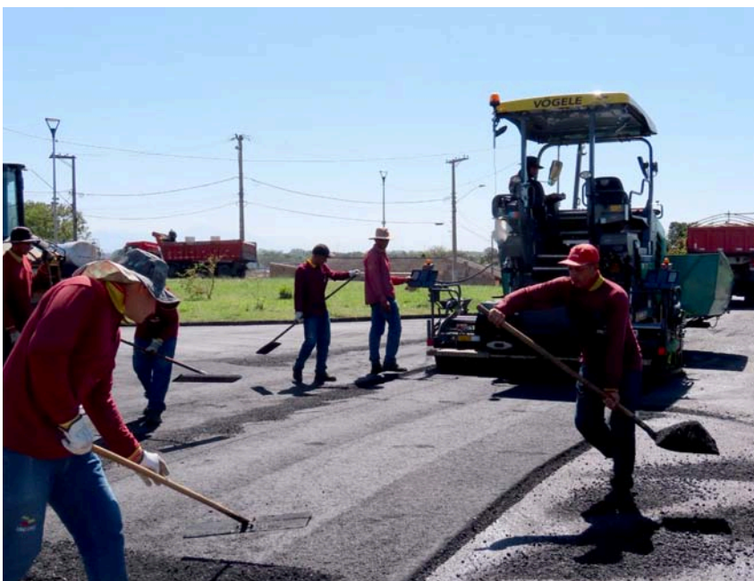
Obras garantem segurança à população
