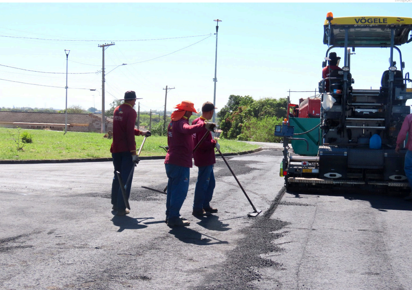
As obras de pavimentação vão beneficiar 26 bairros de Pinda
