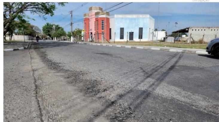
Os trabalhos no Vale das Acácias seguem com a fresagem do solo para posterior aplicação da nova camada asfáltica
