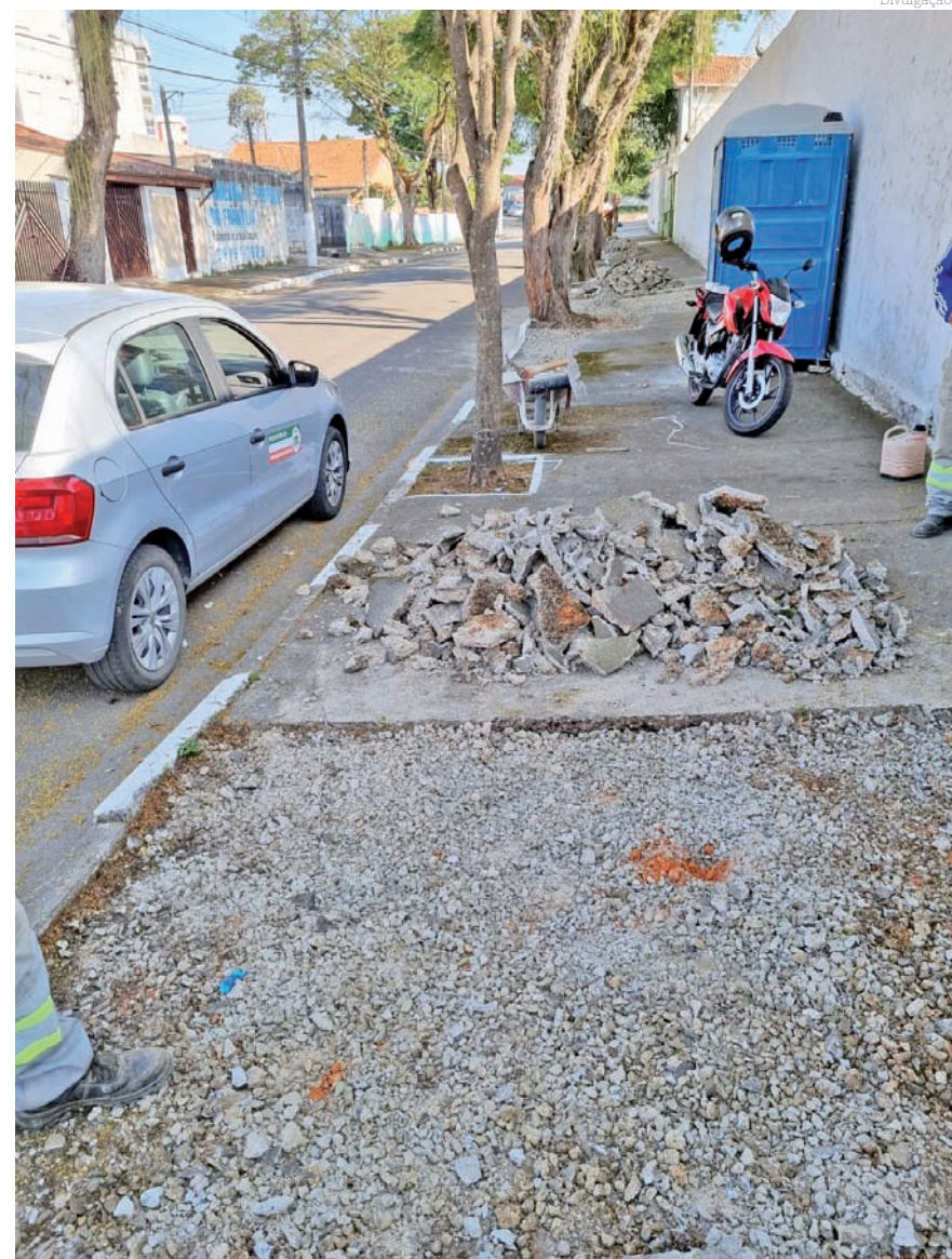
Calçadas laterais do Cemitério Municipal estão sendo reformadas
